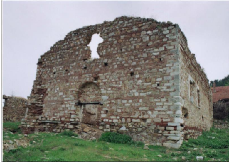
Şekil 4.7. Aya Yani Kilisesi Güneybatı'dan Genel Görünümü
