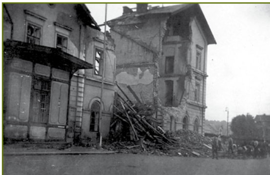
Poničené nádraží při pohledu z Nádražní ulice.
