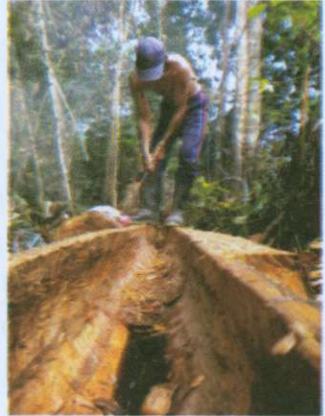
Membuat bakal jukung dengan teknik dugout
