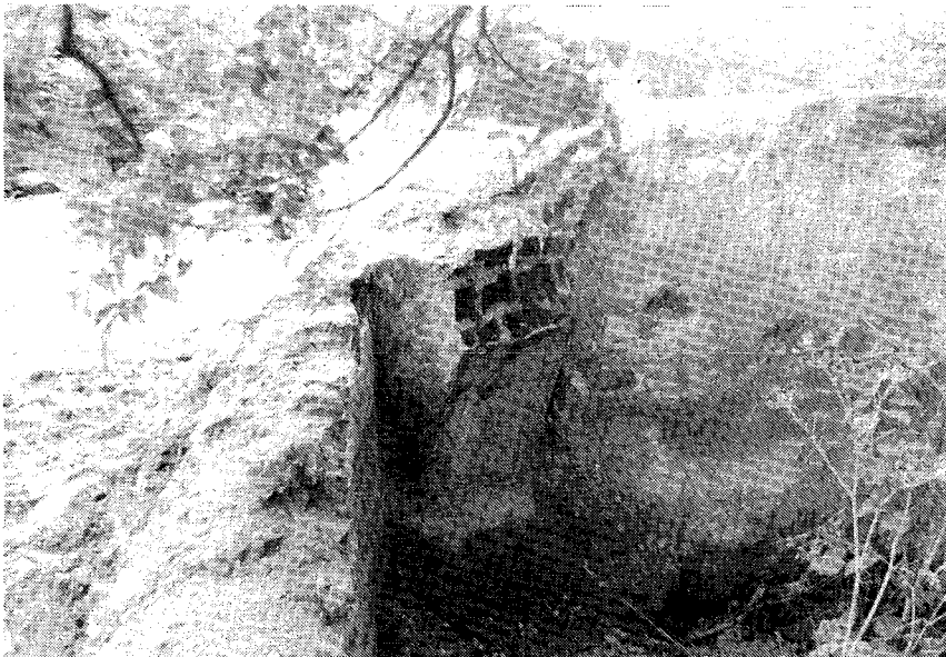
Deel van een kelder muur met aanzet van een kruisbooggewelf; juli 1980
