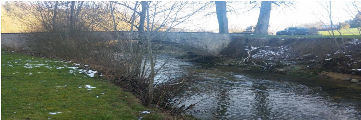
Abbildung 4 Brücke über die Glatt bei Flawil
