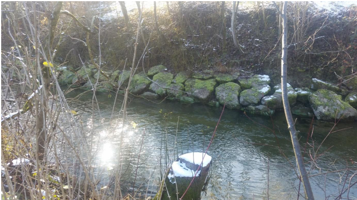
Abbildung 3 Uferbefestigung an der Glatt bei Flawil.
