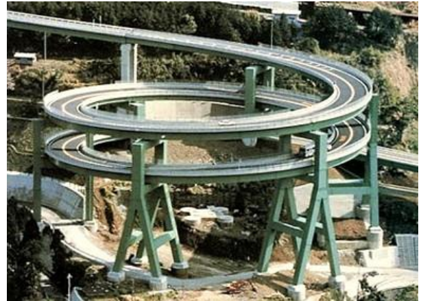
図7 静岡県七滝(ななたる)ループ橋
