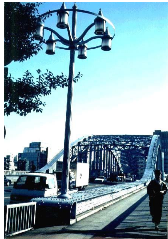
図10 永代橋 1926 (撮影 白井 裕)
