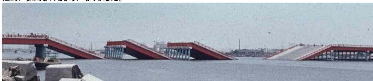
図5 新潟地震時、昭和大橋の落橋,1964(撮影:倉西 茂)
