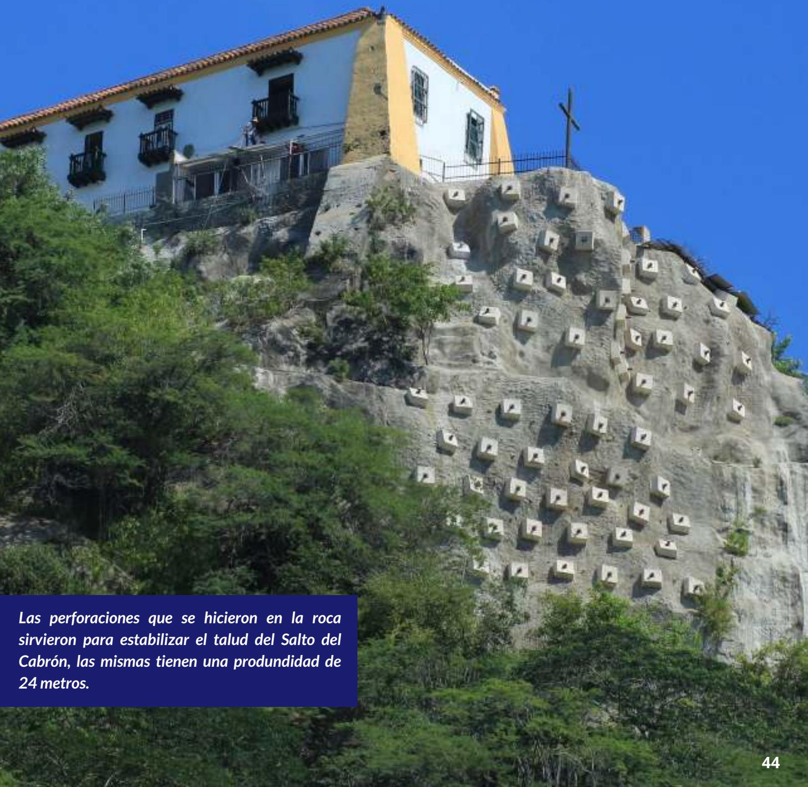
*Las perforaciones que se hicieron en la roca sirvieron para estabilizar el talud del Salto del Cabrón, las mismas tienen una profundidad de 24 metros.*
