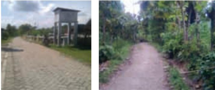
Foto 1: Kanan jalan konblok atau *paving* dan kiri *makadam* yang berada di Dusun Jepang
