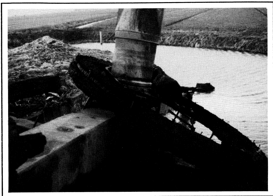
9. De askop, met er omheen het overblijfsel van het door J. Cnossen voor enige jaren terug nieuw gemaakte asrad. Alle teer is van de roeden afgebrand, de menielaag zit er echter nog op. Het merk van de as: L.I. Enthoven 's Hage - 1876 nr. 623.
