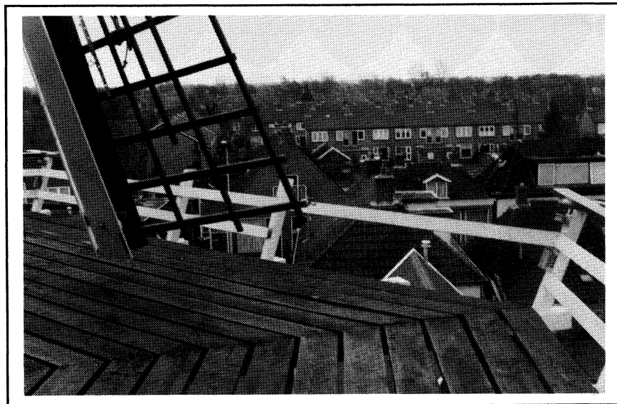
In Wolvega werd op "Windlust" een angstaanjagende stormkracht beleefd. De roedehaak "trok recht" en het gevluht ging met zijn grote fokwieken door de vang. Het stellinghek (balie) liep schade op.
