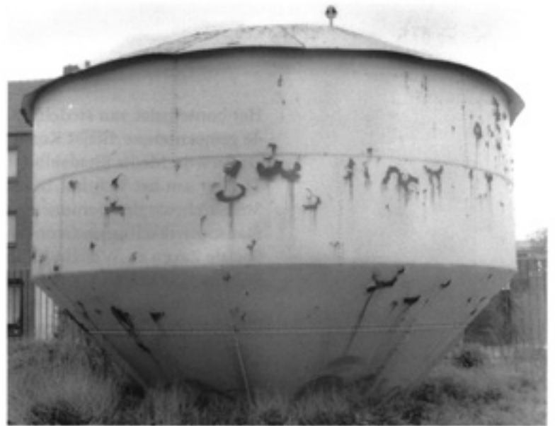
Het 'waterslot' van de fabriekstoren van de Ceramique die moest worden gesloopt, maar zou worden heropgebouwd.
