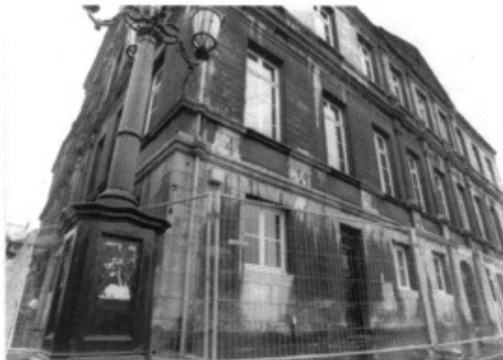
Het begint met Heras-hekwerk, maar binnenkort verschijnt er zwaar verankerd hekwerk rond het stadhuis en veel, heel veel steigerwerk.
