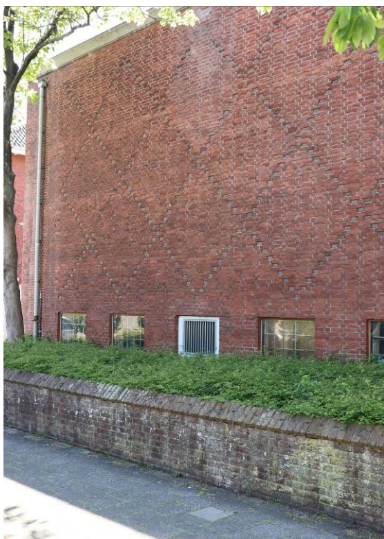
Detail van het siermetselwerk in de oostelijke gevel van de noordoostvleugel (L) en de betonnen venster en ingangspartij van het westelijk trappenhuis tegen de noordvleugel (R).
