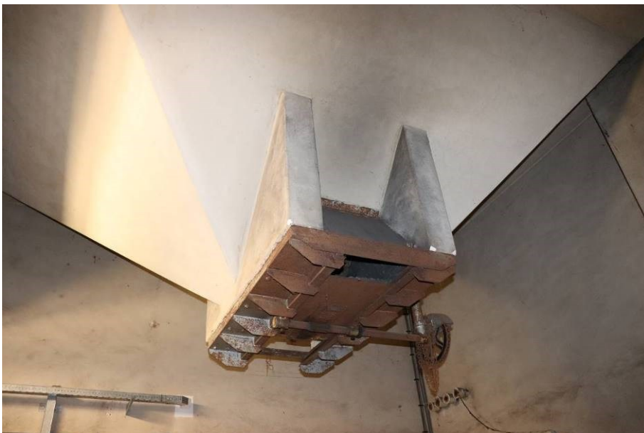
De noordelijke stookkelder, gezien naar het oosten (B) en de onderzijde van een silo met schuifluik om de kolentoevoer te reguleren (O).
