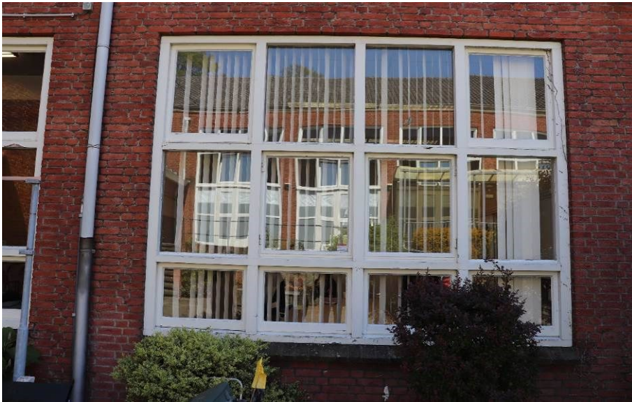
Venster in de zuidgevel aan de oostelijke binnenplaats.
