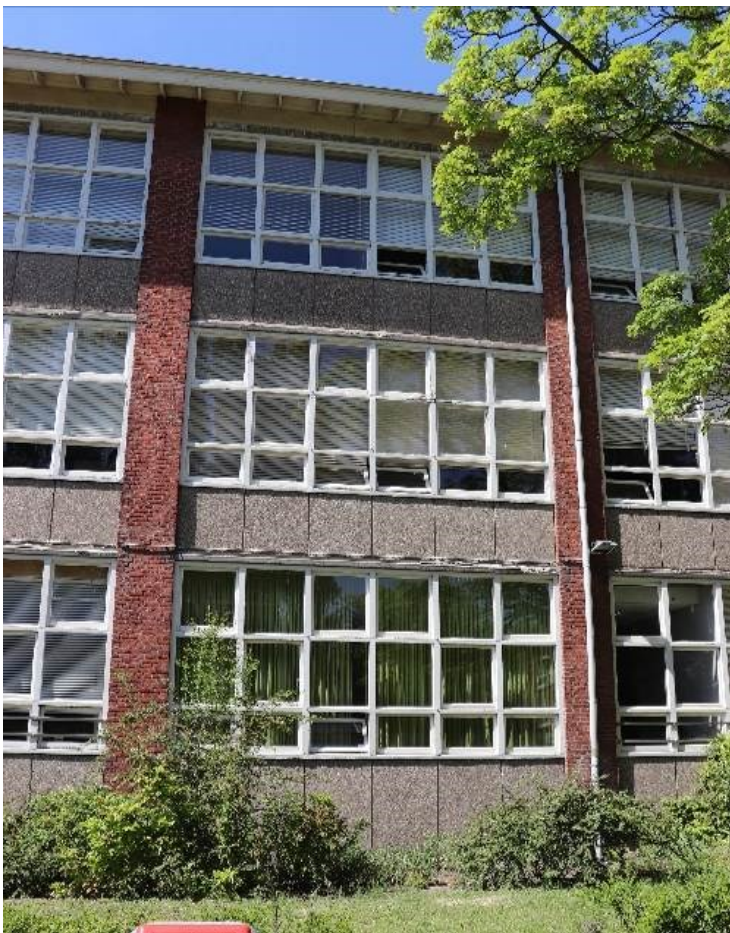
Detail van de gevel van de noordvleugel aan de tuin.
