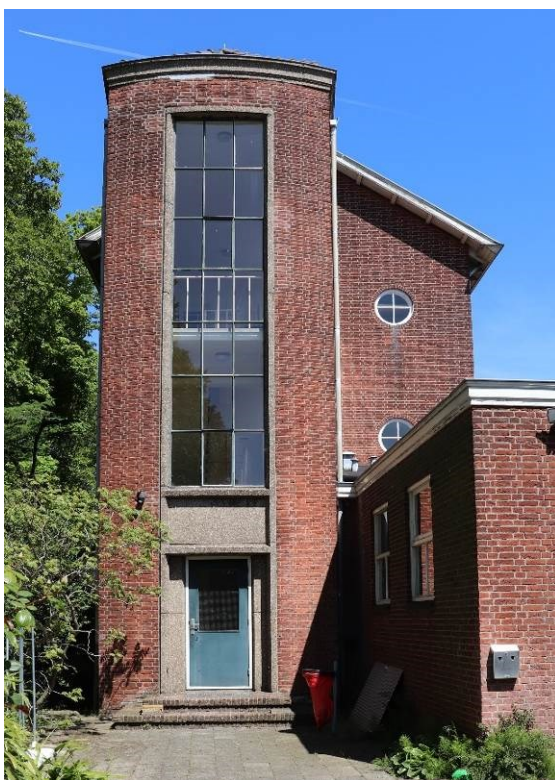
Detail van het siermetselwerk in de oostelijke gevel van de noordoostvleugel (L) en de betonnen venster en ingangspartij van het westelijk trappenhuis tegen de noordvleugel (R).
