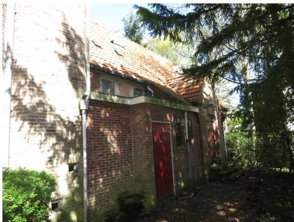
21. Zuidelijk deel van de oostgevel van de vroeg 20e-eeuwse hobbyruimte-consistorie met rechts ingangspartij met steekkap. De ingang zelf is met enkele treden toegankelijk, aangezien het gebouwtje al vanaf het begin onderkelderd was. Links de toegang tot deze kelder, die bij de bouw van de huidige kerk ook als verwarmingsruimte in gebruik bleef.
