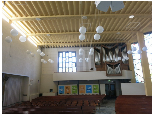
25. Gezicht in de kerkzaal naar het zuiden met tegen de zuidwand de tribune met het orgel. De zoldering bestaat uit een betonconstructie in de trant van moer- en kinderbinten. In de linker wand (oost) is de opening naar de ruimte voor de avondmaalsviering. Aan de bovenzijde van de oostmuur is onder de zoldering een reeks bovenlichten.
