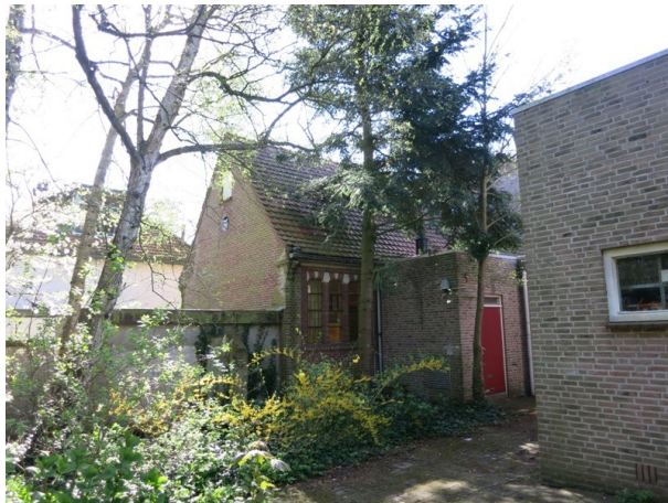
20. Gezicht op de noord- en westgevel van de consistorie-hobbyruimte (links). Opvallend zijn de rijk versierde geblokte bovendorpels van de gekoppelde Tudorvensters. Tegen de westgevel staat een aanbouw uit de jaren 70 van de 20e eeuw. Geheel rechts de nieuwbouw van de kerk uit de jaren 70 van de 20e eeuw.
