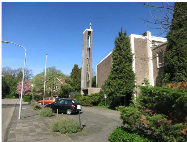
14. Gezicht op de zuidgevel van de kerk naar het westen, met de vrijstaande toren bestaande uit twee verbonden baksteenschillen.
