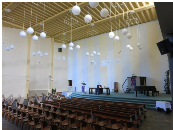
26. Gezicht in de kerkzaal naar het noordwesten met rechts tegen de noordwand het niet oorspronkelijke podium met de preekstoel. De zoldering bestaat uit een betonconstructie in trant van moer- en kinderbinten.
