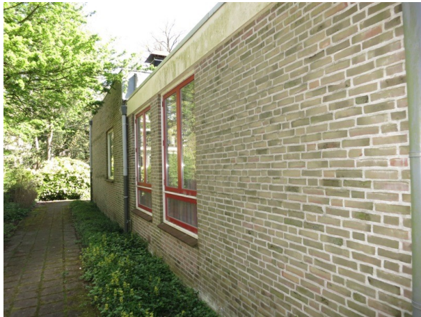
19. Gezicht op de noordgevel van het kerkgebouw. Dit deel is in de jaren 70 van de 20e eeuw toegevoegd.
