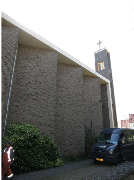
18. Gezicht op de westgevel vanuit het noordwesten.
