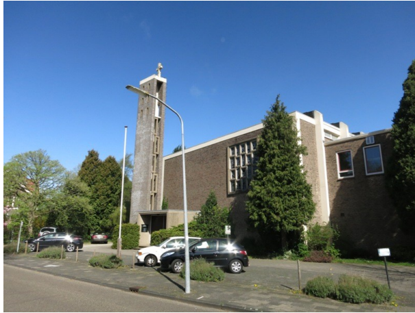
16. Overzicht van het rechterdeel van de zuidgevel van Vijverwegkerk vanuit het zuidoosten.
