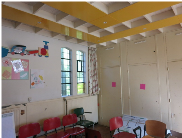
23. Interieur van de hobbyruimte in het noordelijke deel van de vroeg 20e-eeuwse 'consistorie-hobbyruimte'. De beide Tudorvensters met glas-in-lood en brugijzers behoren tot de oorspronkelijke detaillering. De rest van de ruimte is in het laatste kwart van de 20e eeuw ingrijpend veranderd.
