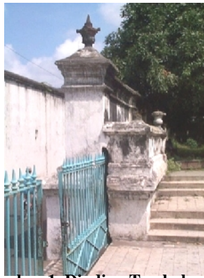
Gambar 1. Dinding Tembok Pembatas Bagian Selatan Sitihihgil Utara
