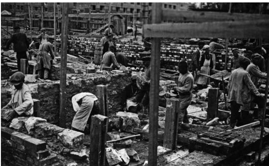
Рабочие на строительстве жилого комплекса ОГПУ.
