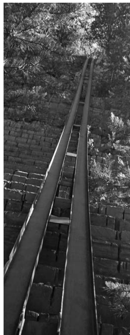
По этим рельсам спускали насосы и трубы для откачки воды.
