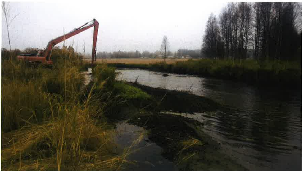
Kuva 1. Pitkäpuomikone aloittelemassa ruoppauksia Lehmipuron alla. Sisäkurviin oli kertynyt hiekkaa reippaasti, muuten kasvillisuus oli kadonnut liki kokonaan suunnitelman laadinta hetkestä (2011).
