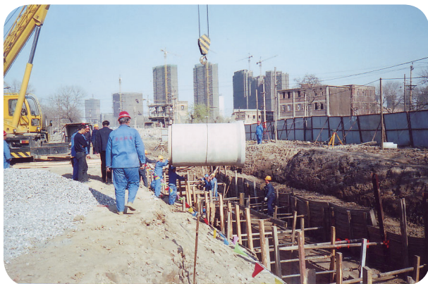
照4-10 新三条石大街排水工程
