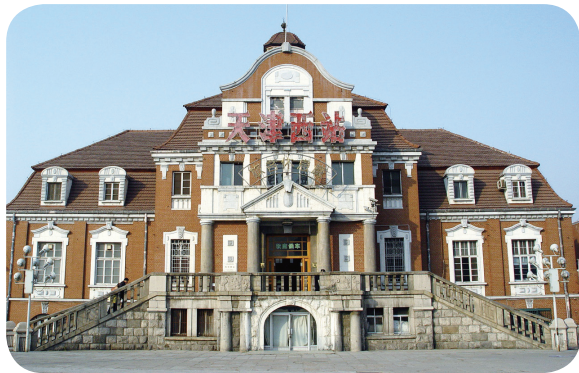
照4-13 天津西站主楼老站房 (区建委提供)
