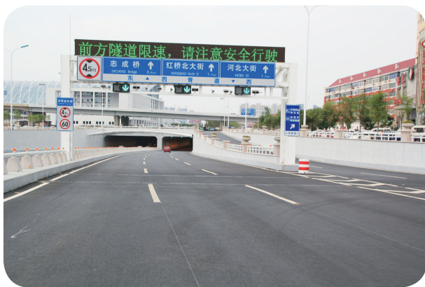
照4-2 西青道下沉隧道 (区市政局提供)
