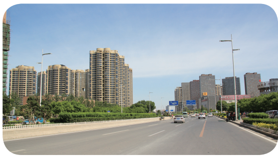
照4-1 拓宽后的河北大街 (区市政局提供)
