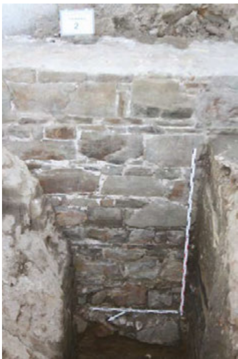
Afb. 8.33 De stadsmuur opgebouwd van blokken 'kolenzandsteen' (Carboon zandsteen) aan de Roerkade 15 (naar: Van Diepen & Gazenbeek 2014, 40: afb. 32).
