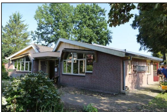
Afb. 2.25: Voorkant en oostelijke zijgevel van de Steniaschool. Situatie omstreeks 2016. (Bron: Mooi Zeist BV.)
