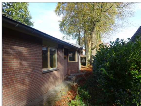
Afb. 1.14: Zicht langs de oostgevel van de Steniaschool, richting de fietsstalling achter op het perceel.
