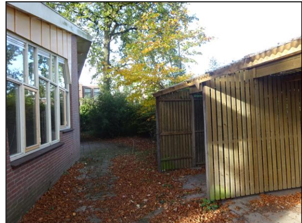
Afb. 1.13: De achterzijde van de Steniaschool met fietsstalling tegen de noordelijke perceelsgrens.
