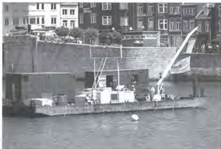
Het zicht op de Maasbodem was nog geen meter
