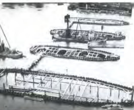
In 1930 start de bouw van de pijlers van de Wilhelminabrug
