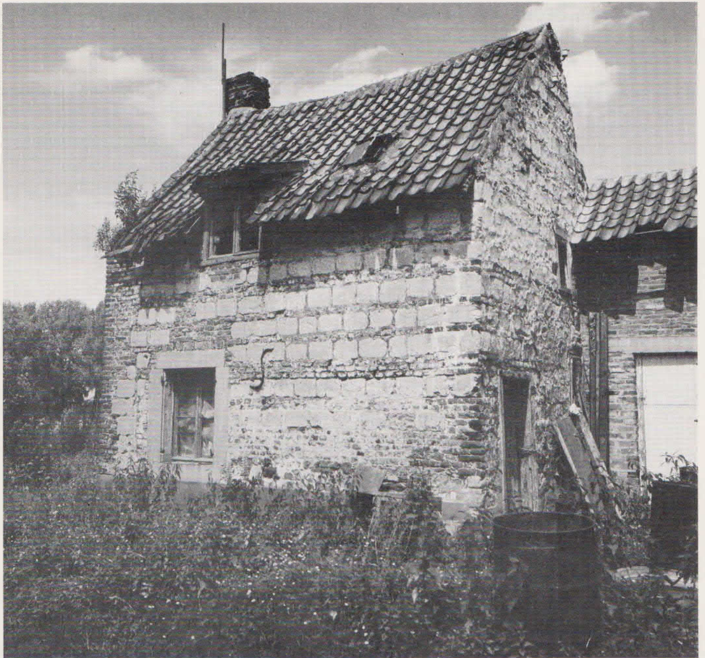
△ Monumentaal huisje met speklagen en hardstenen raamomlijstingen in Laag Caestert. (Foto: Paul Rutten)
