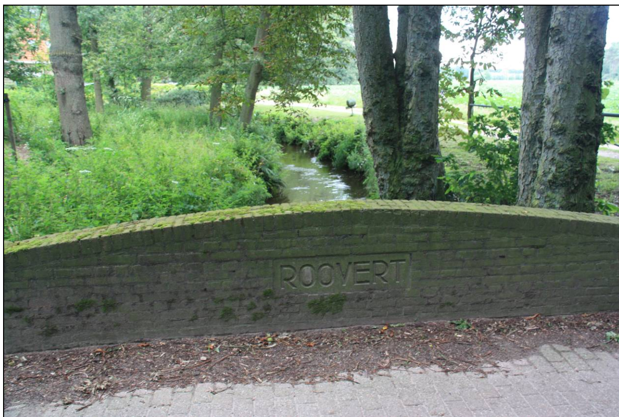
De brug over de Rovertsche Leij in de weg van Rovert naar Poppel.
