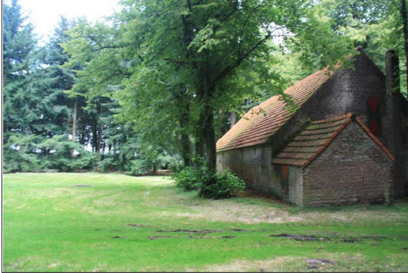
Noordelijke zijgevel en achtergevel met erf en aanbouw.
