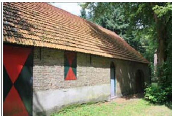
De zuidelijke zijgevel.
