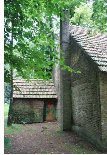
Aanbouw en schoorsteen.
