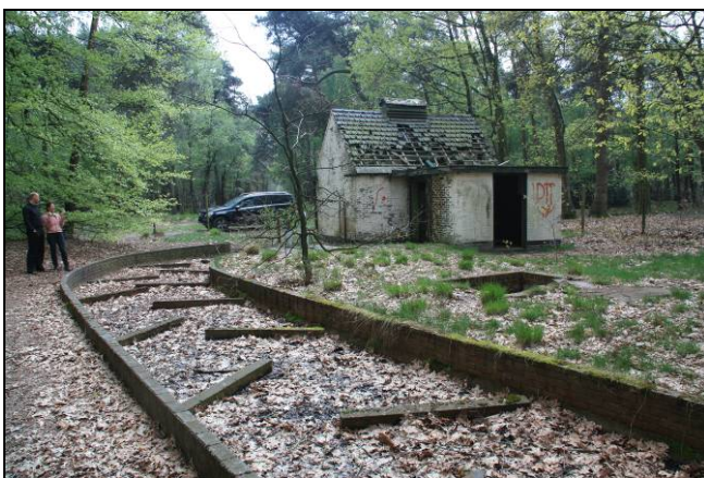
Pomphuis en stroomgoot.
