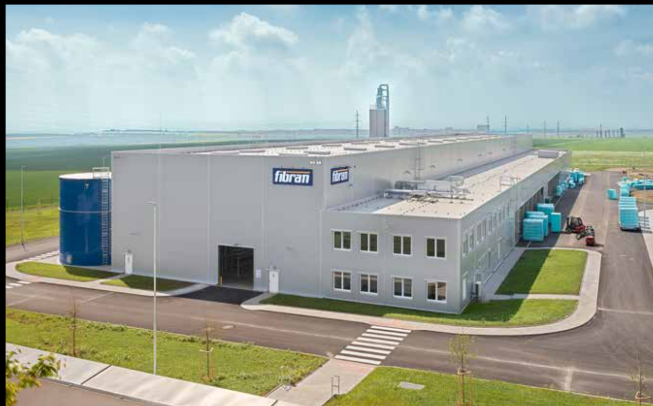
Výrobní hala FIBRAN, Most; FIBRAN production hall, Most
