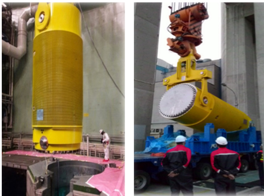
Рис. 21.1. Современный ТУК-153 на энергоблоке АЭС с РУ ВВЭР-1000
