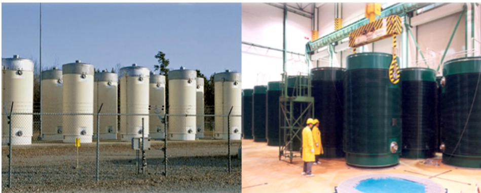
Рис. 21.4. Примеры хранилищ ОЯТ с использованием двухцелевых контейнеров
