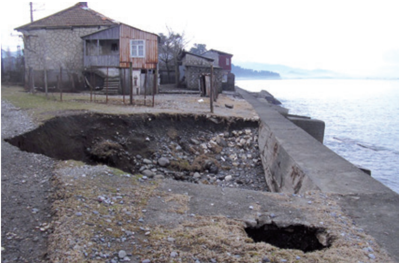
სურ. 6.1.5. ტალღის მიერ კედლის უკან გამორეცხილი ქაბრისებური ფორმა
