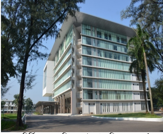
নবনির্মিত একাডেমিক ভবন ‘শেখ হাসিনা কমপ্লেক্স’
