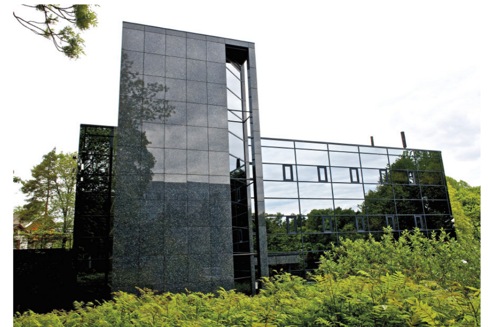
Tandbergbygningen i Bærum. Her har arkitekten fullstendig forelsket seg i larvikitt og slik gitt kontorbygget et særpreg utenom det vanlige. (Foto: Lundhs AS/M. Rakke)
