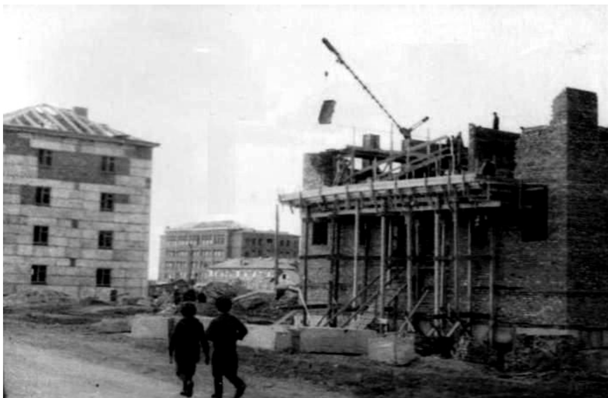
пр. Ленина, строительство кинотеатра «Космос», вдали видно строящееся новое здание средней школы №1, 1961 г. 12
