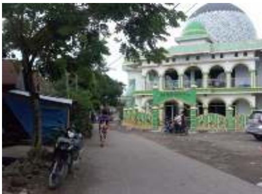
Gambar 32 : Masjid Sumber : Survey Maret 2015
