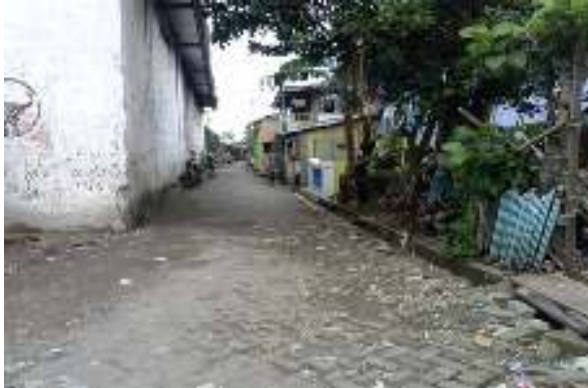
Gambar 38 : Kondisi Jalan Sumber : Survey Maret 2015
