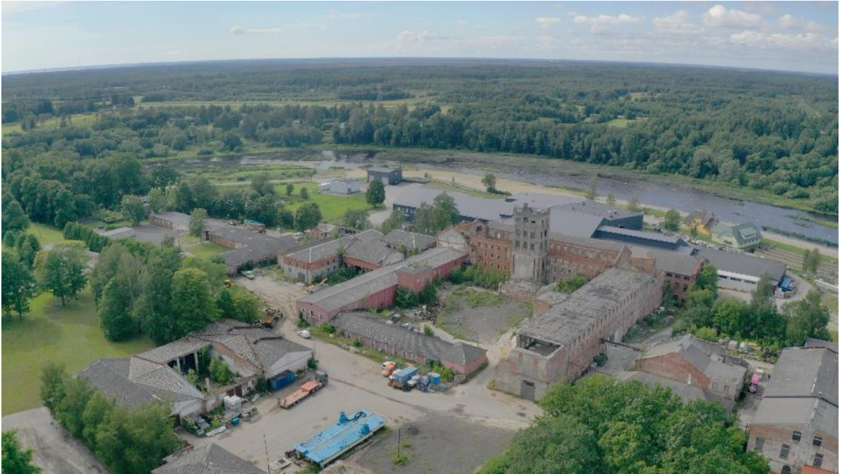
Joonis 4.16. Sindi ettevõtlusala lääne poolne külg: esiplaanil Kalevivabriku hooned, mille taga paikneb Danspin AS tootmishoone. (Foto: Hendrikson ja Ko, 2020)
