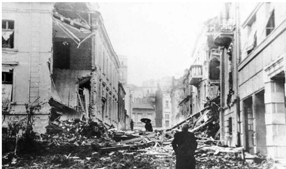
Разрушения в Белграде после бомбардировок в апреле 1941 г.
