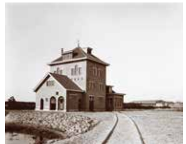
Pompgebouw met waterpoel (1906).
