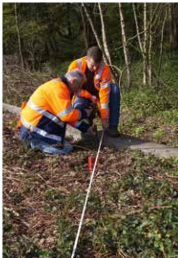
De grens bij het grensstation wordt vastgelegd.
