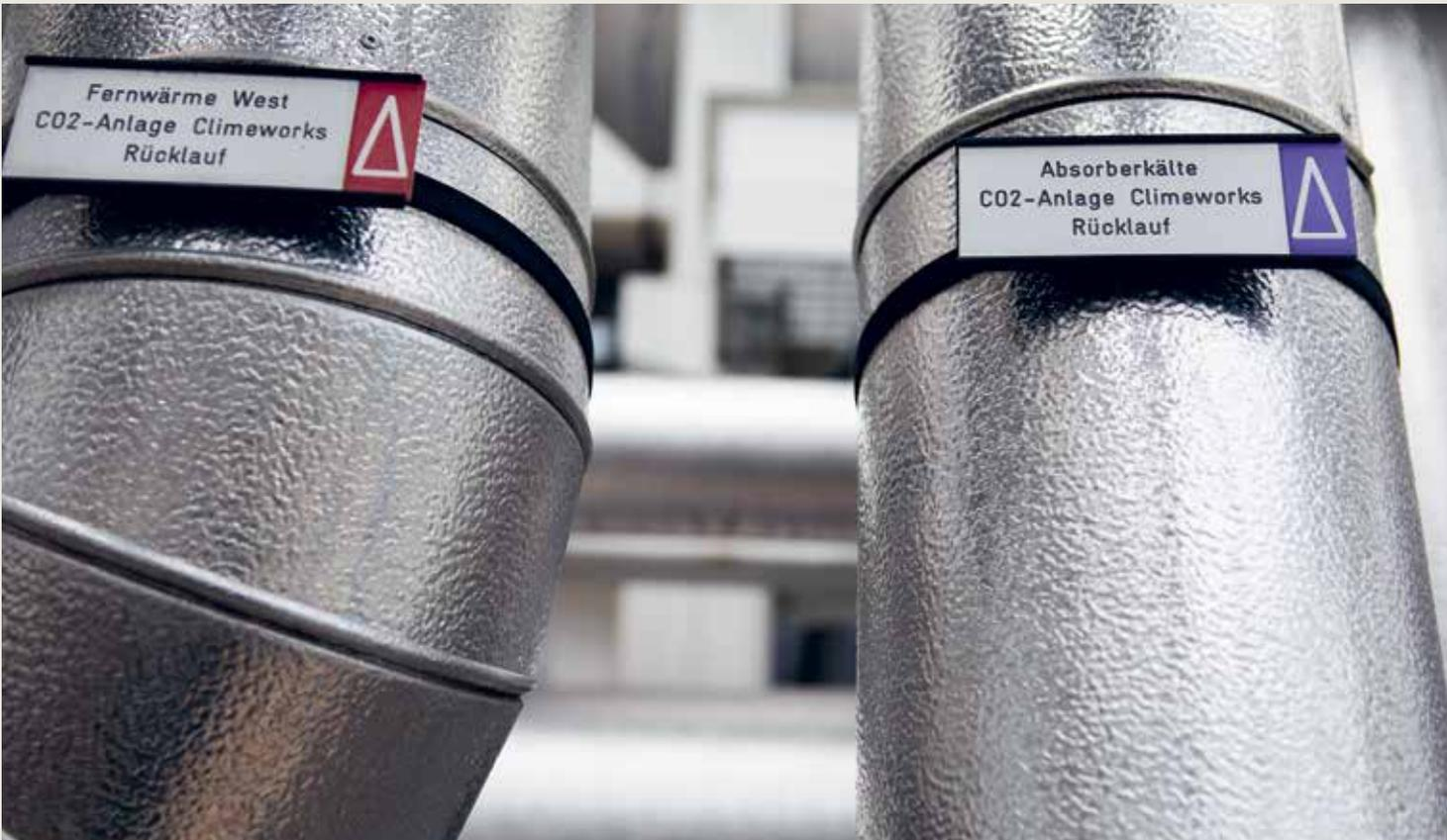
Die Wärme zur Erhitzung der CO<sub>2</sub>-Filter stammt in Hinwil aus der Kehrichtverbrennung.
