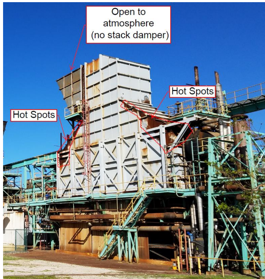
Figure 3-9 — STAG 2 HRSG 2-4
