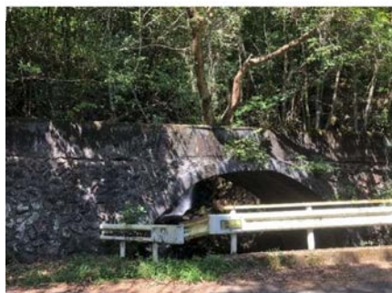
トロッコ道の跡(立野地区)
