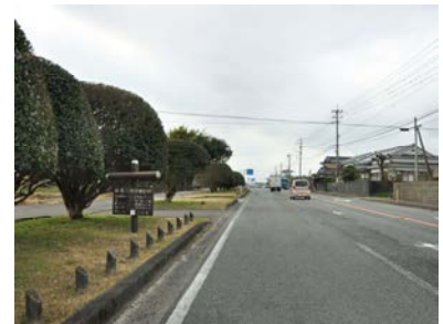
国道10号沿道修景箇所
