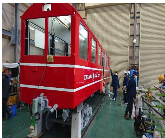
客車スロフ318改修工事
