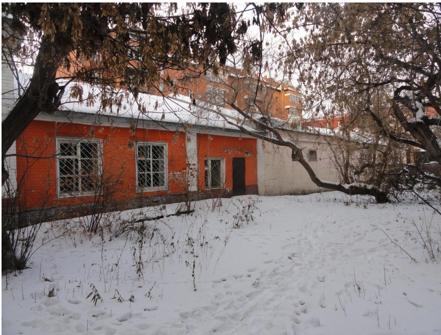
4. «Магазин и склады А.Ф. Поклевского-Козелл». Юго-восточный фасад дворового крыла. Г. Тюмень, ул. Ленина, 31. Фото 2016 г. И. Ганеев
