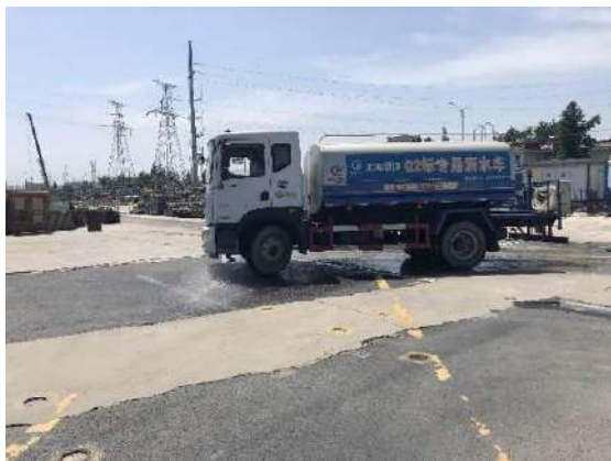
施工现场洒水车
