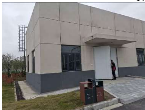
生产废水处理站
