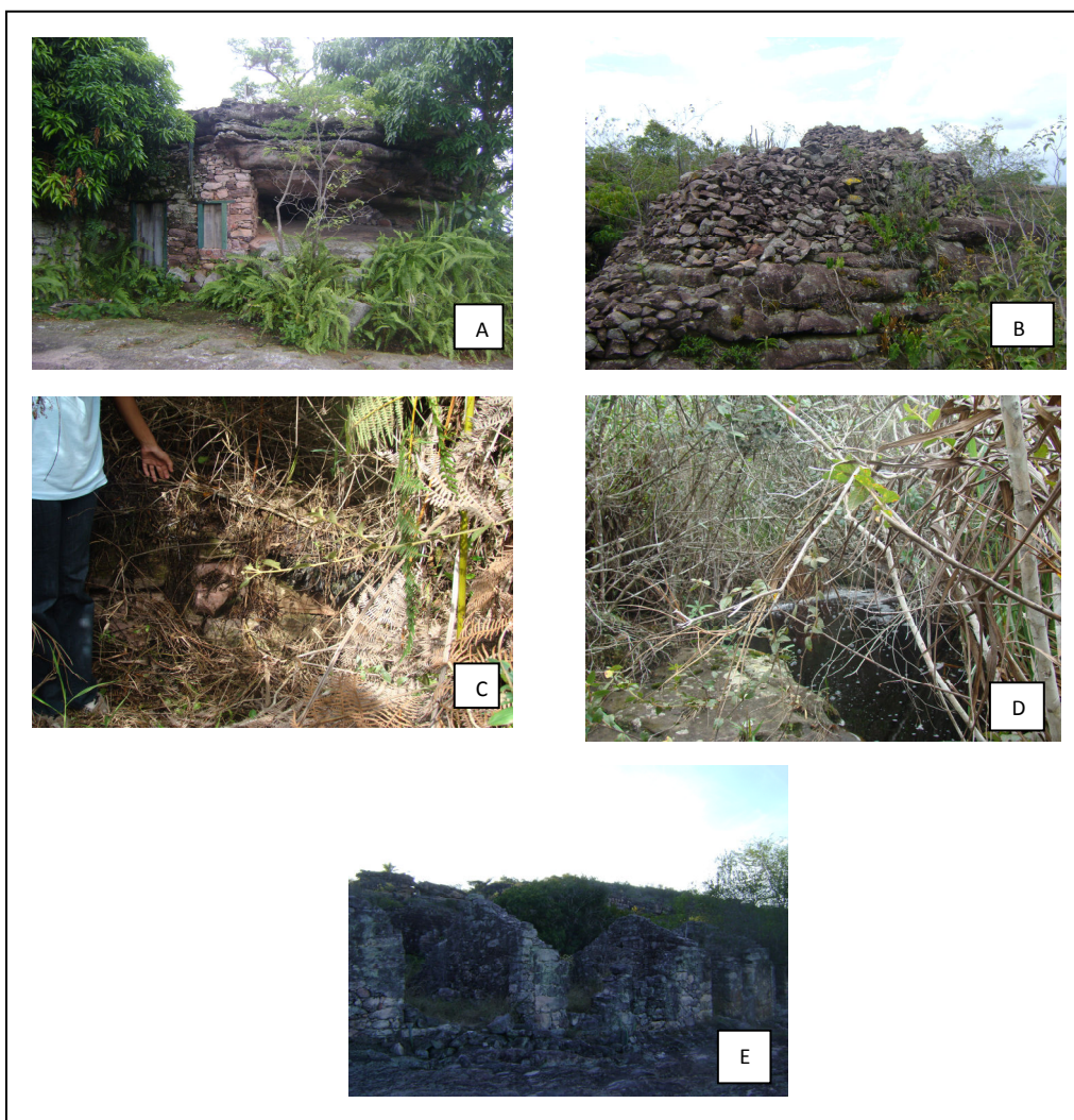
Figura 10: Modificações na paisagem da MCB: (A) Tocas ou locas; (B) Montoeiras de garimpo em área da MCB; (C e D) Barragem construída no Rio Laranjeiras; (E) Ruínas do antigo bairro Luís dos Santos.
