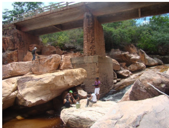
Figura 45: (P20) Ponte sobre a rodovia BA 142, sobre o Rio Cousa Boa, prestes a desaguar no Paraguaçu.
