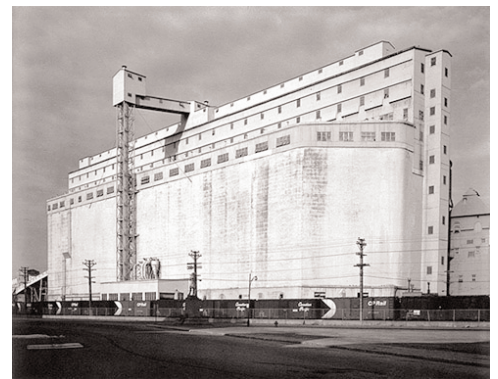
David Miller, Silo à céréale no. 1, vue sur la facade ouest, 1976, épreuve à la gélatine argentique virée au sélénium et à l'or, 19,4 x 24,4 cm.
