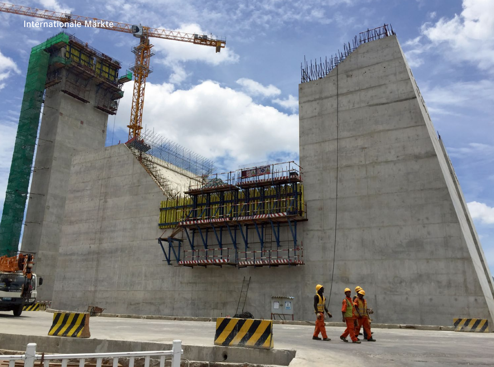
Der 170.000 t schwere Ankerblock auf der Nordseite.
