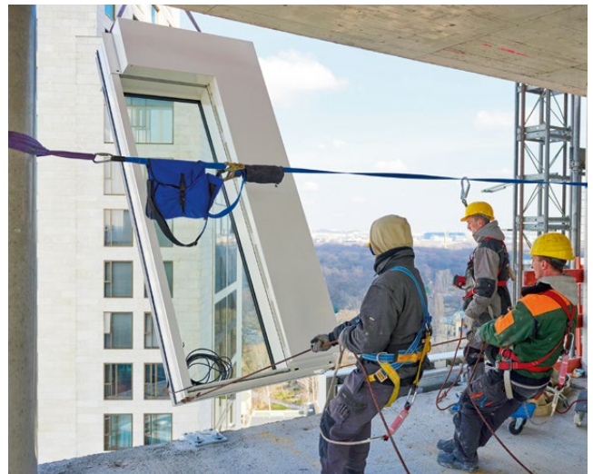
Anlieferung der Fassadenelemente per Kran.
