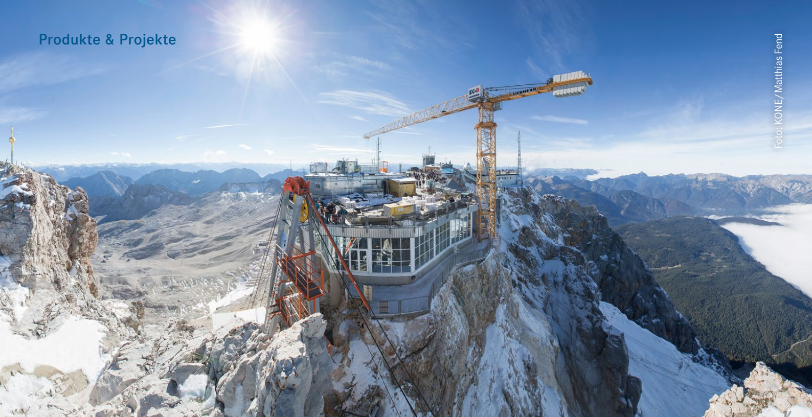
Auf der Zugspitze wird derzeit der höchst gelegene Aufzug Deutschlands installiert.
