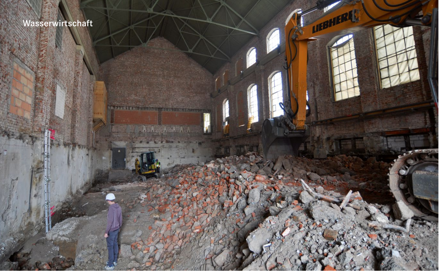
Abbrucharbeiten im Inneren des Bestandsgebäudes
