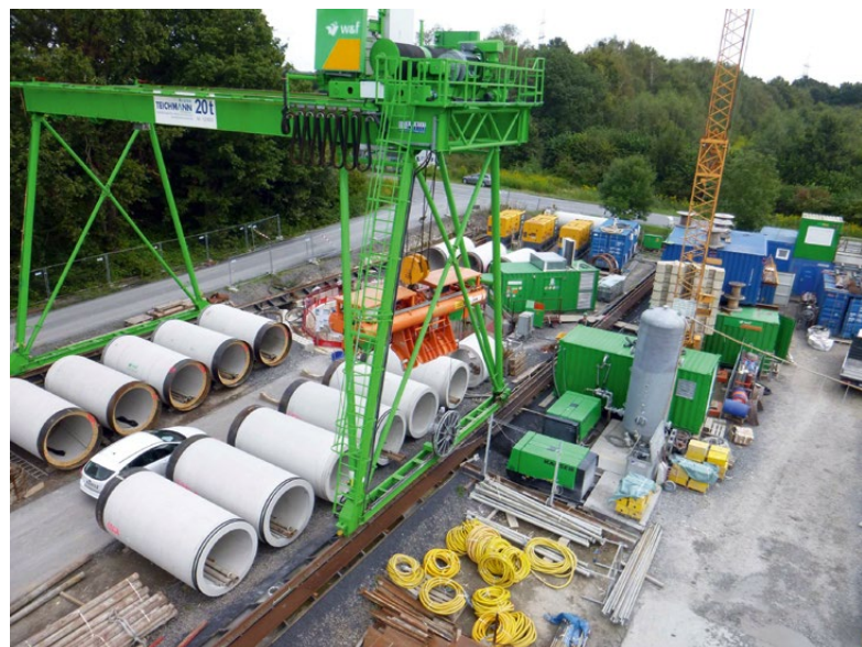
Startbaugrube, Vakuumhebeanlage
