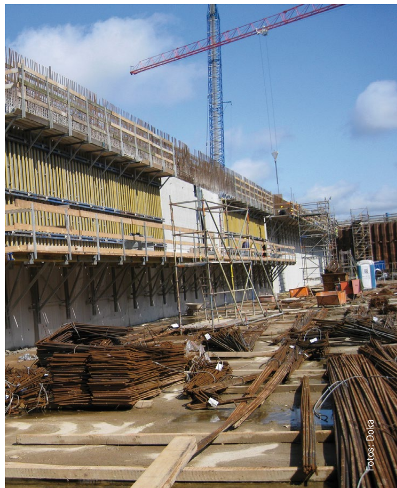
Im Pilgerschritt-Verfahren werden jeweils 15 m lange und 3,90 m hohe Wandabschnitte betoniert.
