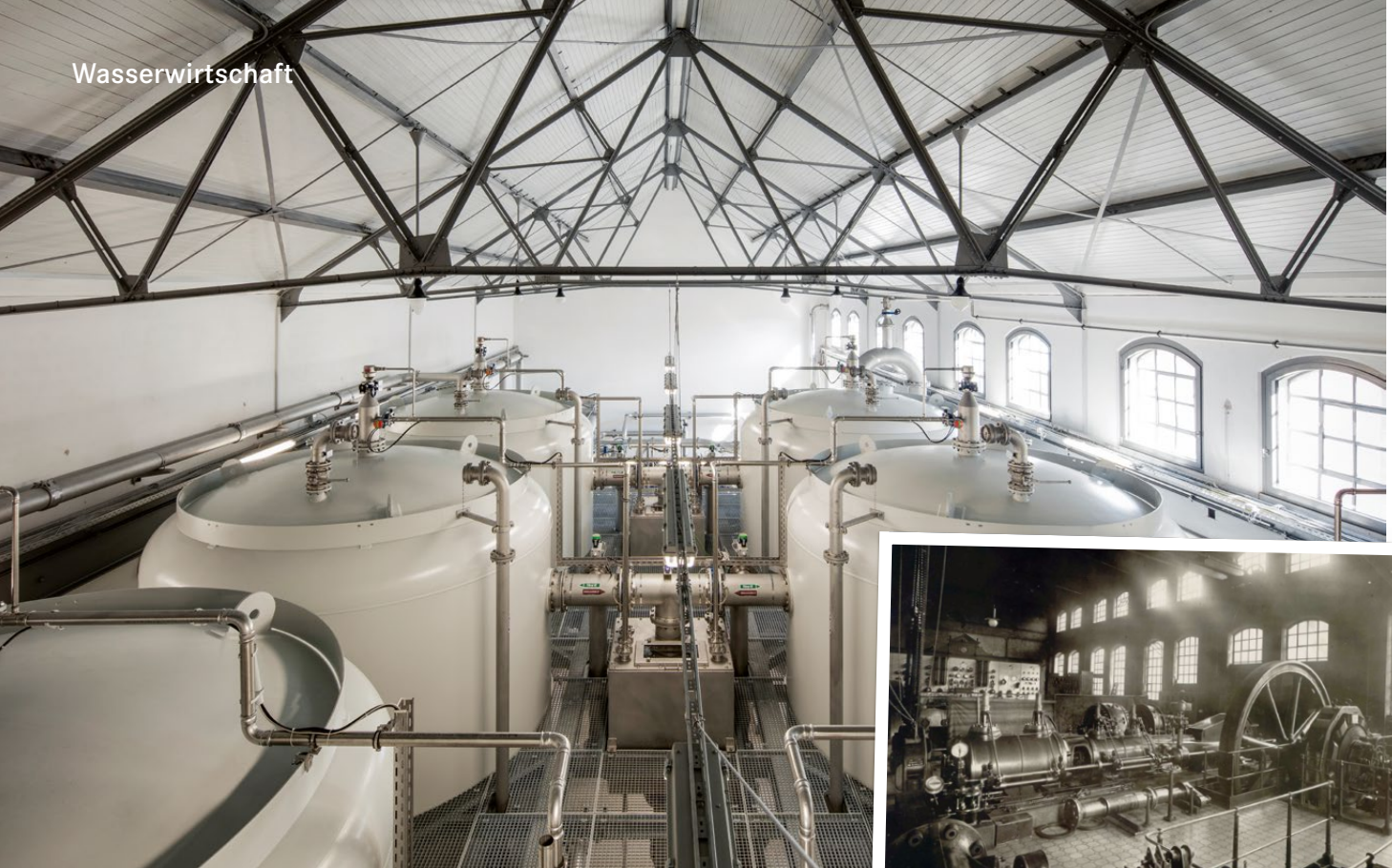
Ansicht Aktivkohlefilterkessel nach Fertigstellung
