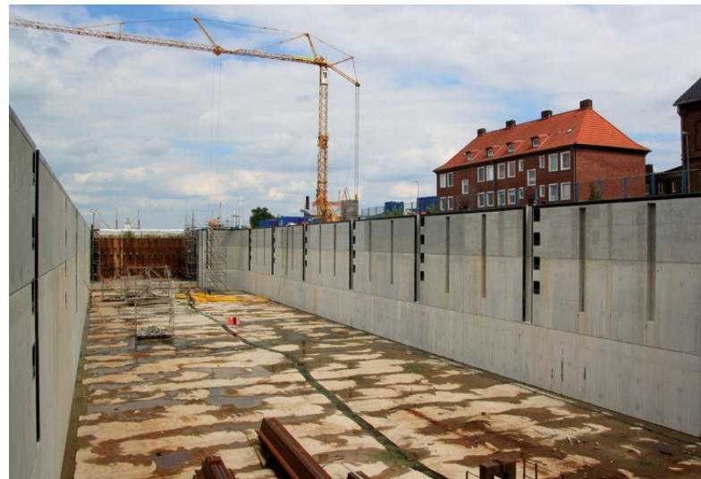
Für die Sanierung der Nesserlander Schleuse liefert Doka die Schalungstechnik.
