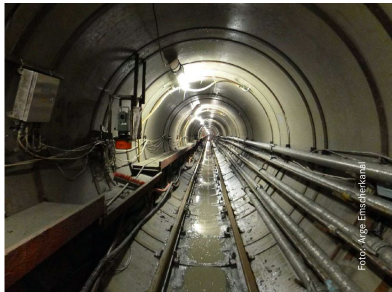
Vortrieb DN 2800 mit Erdruckschild
