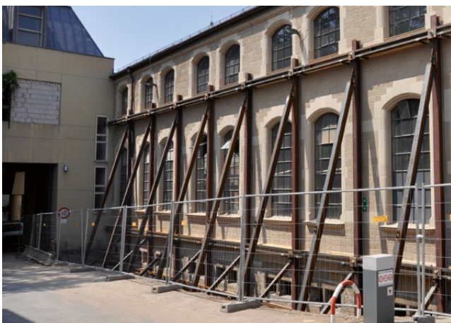
Bauwerkssicherung außen
