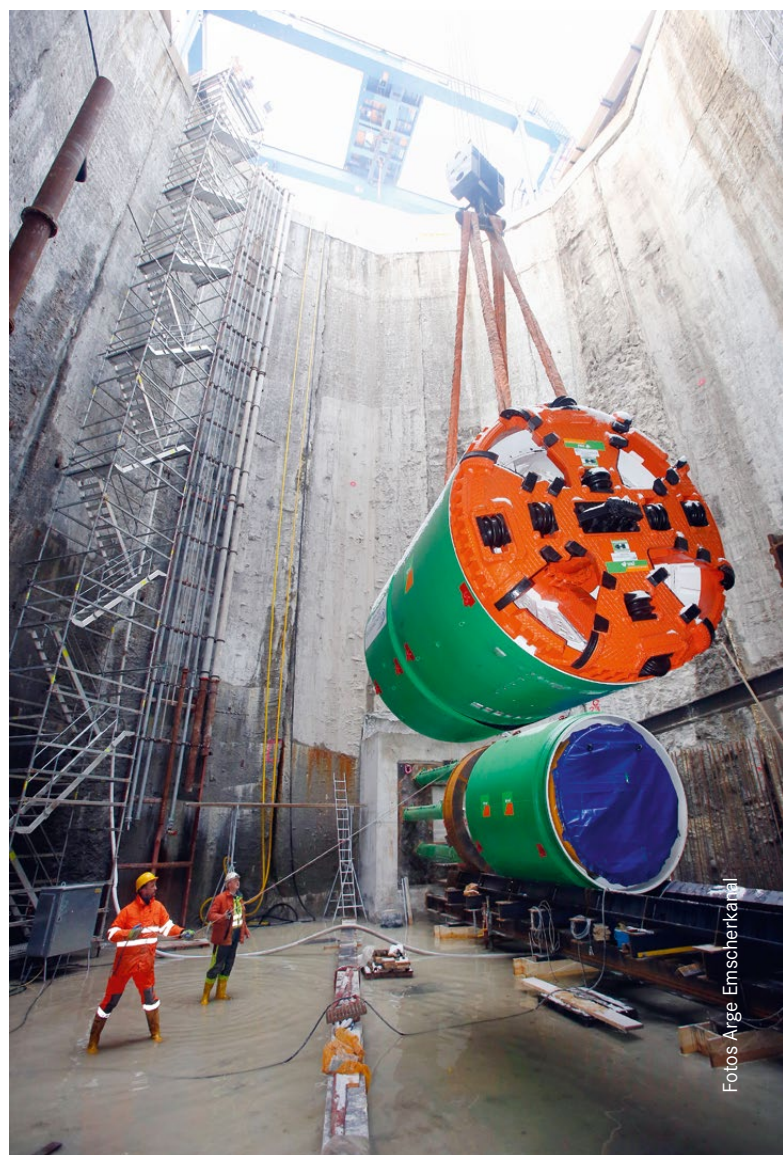
Einheben der TBM
