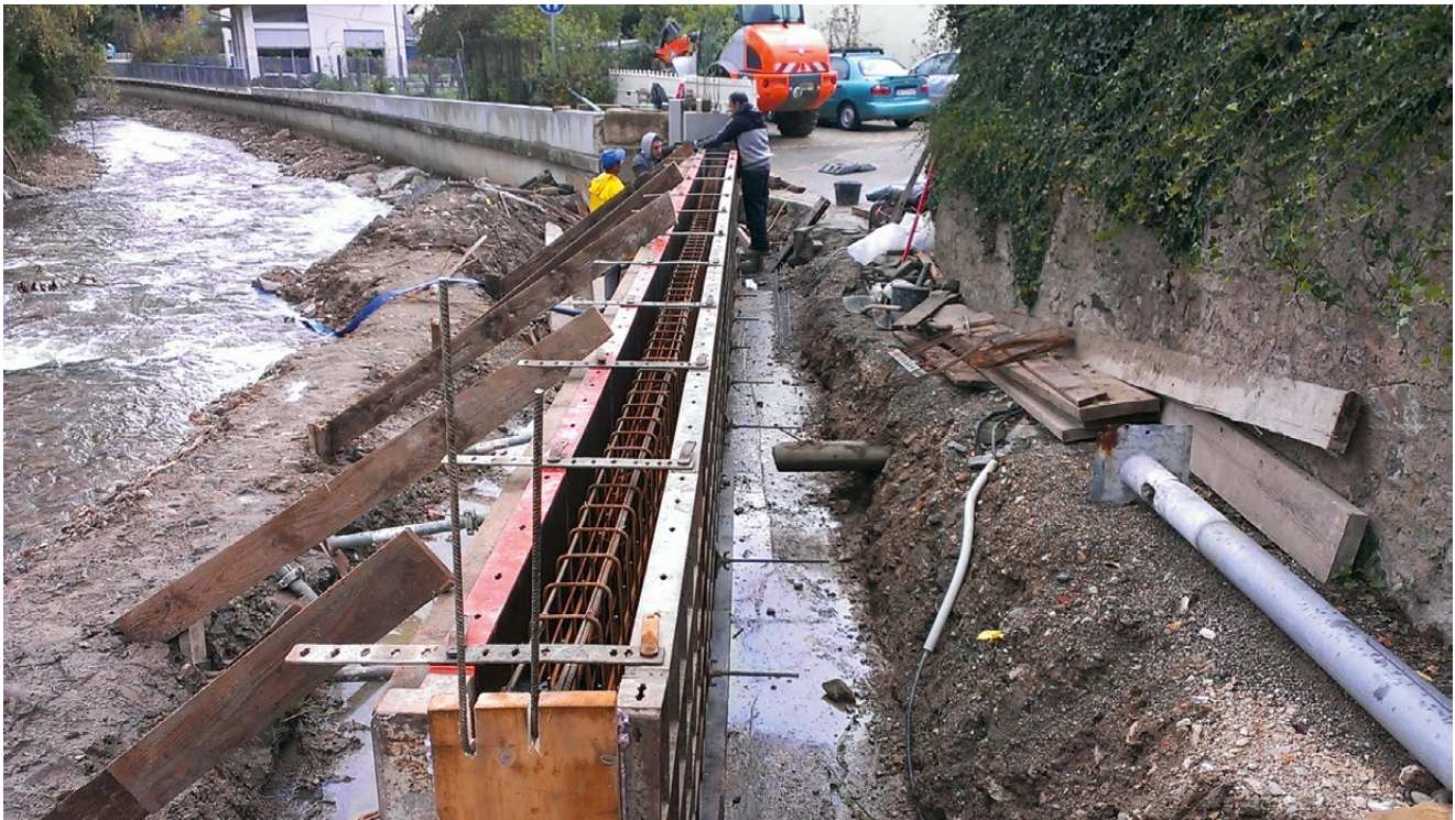
Effektiver Schutz vor Überflutung bei Hochwasser: eine Schutzmauer
