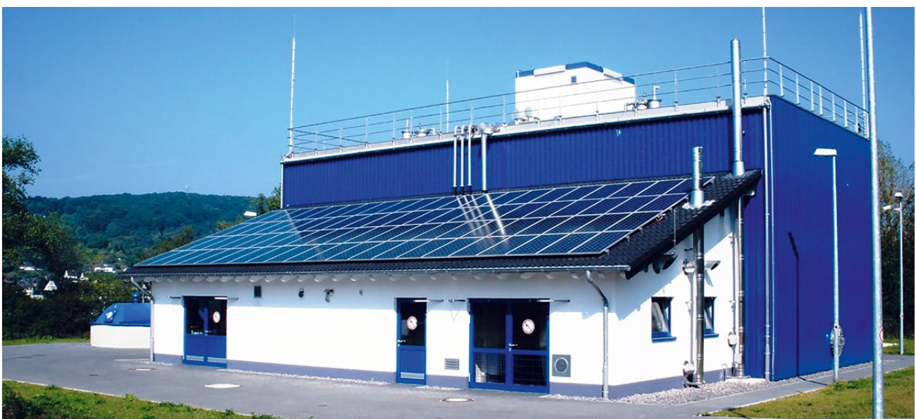
Kompaktfaulbehälter mit Technikgebäude auf der KA Linz-Unkel
