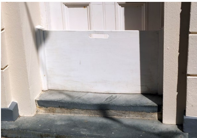
Objektschutz mittels Wassersperre
