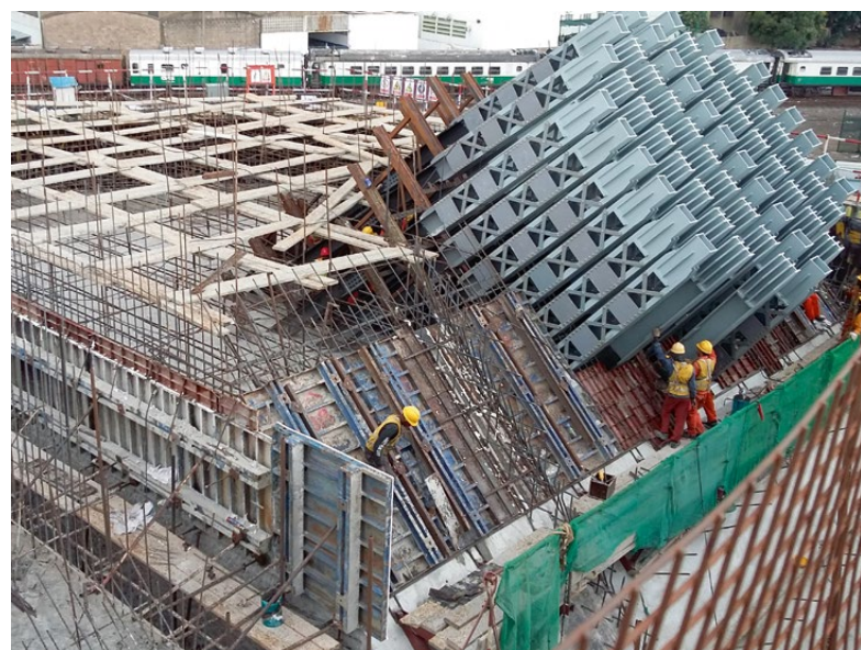
Einbau der Stahlteile aus China für die Hauptseilverankerungen auf der nördlichen Seite.
