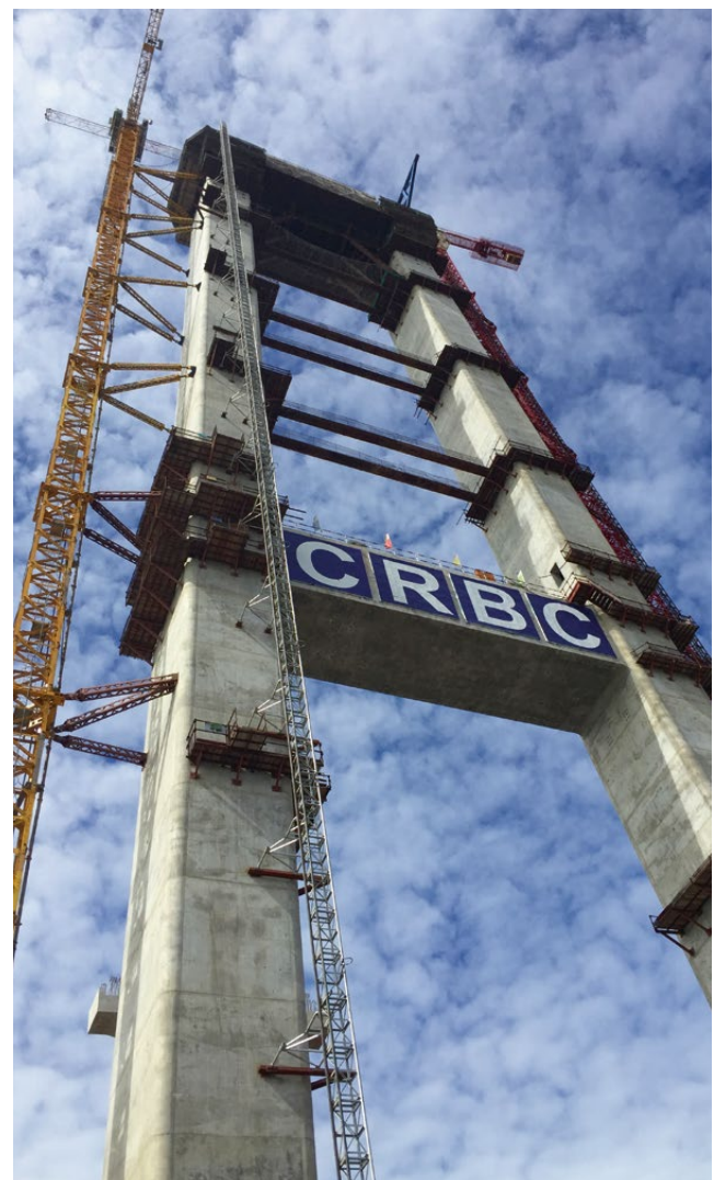
Die Pylone „wachsen“ stetig in den Himmel bis auf 141 m Höhe.
