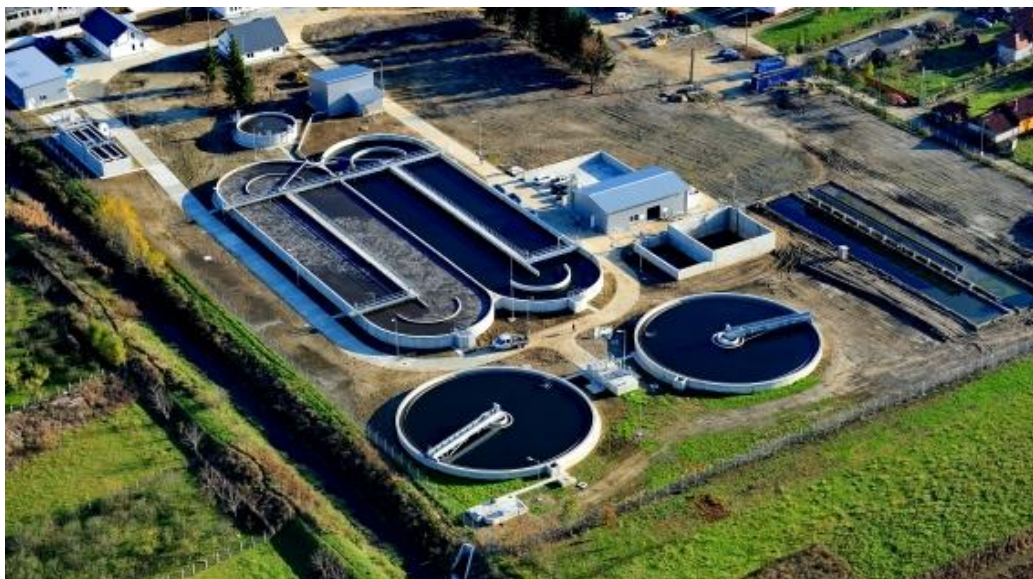
Figura 39. Stația de epurare a apelor uzate Sighetu Marmației (2016)
