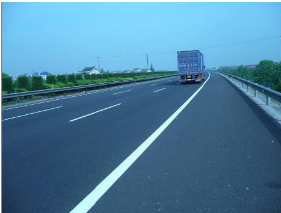
图3.3-1 绕城高速公路现状图
