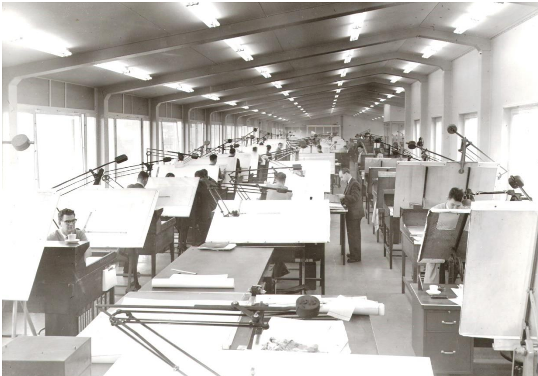
Tekenkamer Smit Transformatoren 1949. Bron: Personeelsblad Smit Transformatoren
