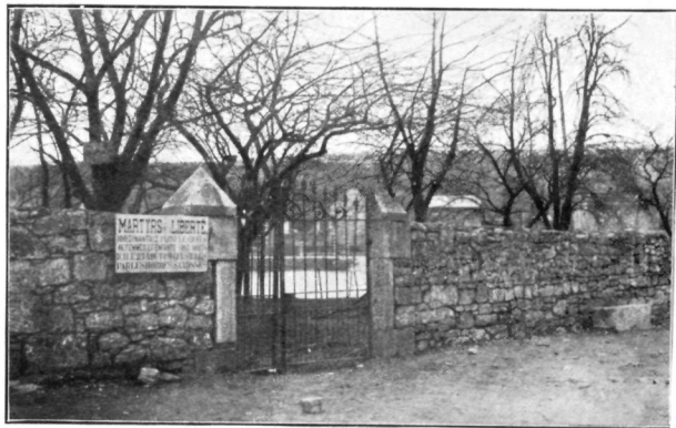
Fig. 133. — Le mur Bourdon aux Rivages.
