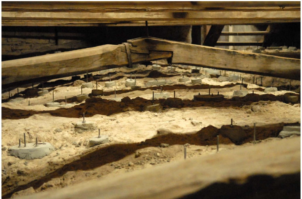
▲ Gewölbe von Oben mit den Gewindeankern
