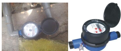
Gambar 5. Pemasangan meteran air
