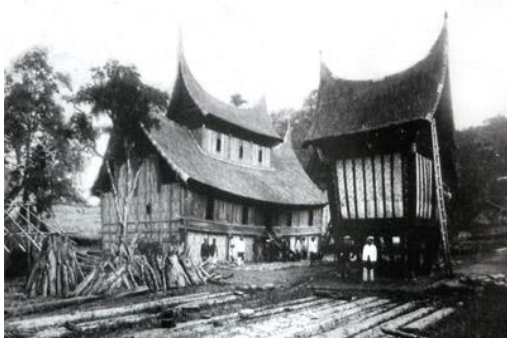
Gambar 5. Penempatan dan model ukiran mirip dengan bangunan asli yang ada di Pariangan. Tangga tanpa atap dan lima ruang, ditandai dengan empat buah jendela, ditambah dengan satu pintu masuk di tengah bangunan
