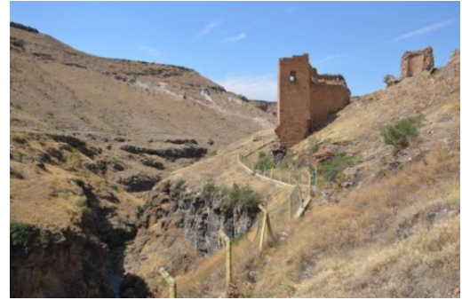
Görsel 89: Recep Ezen, İç Kalede Güneybatı Surları , Fotoğraf, 2019
