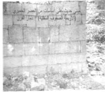
لوحة (١١): أساسات مبنى قديم عليه مبنى حديث.
