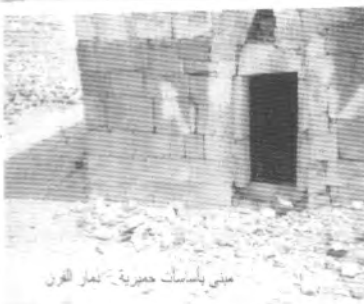
لوحة (١٢): أساسات مبنى قديم عليه مبنى حديث.
