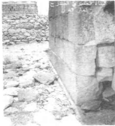
لوحة (١٣): أساسات مبنى قديم عليه مبنى حديث.
