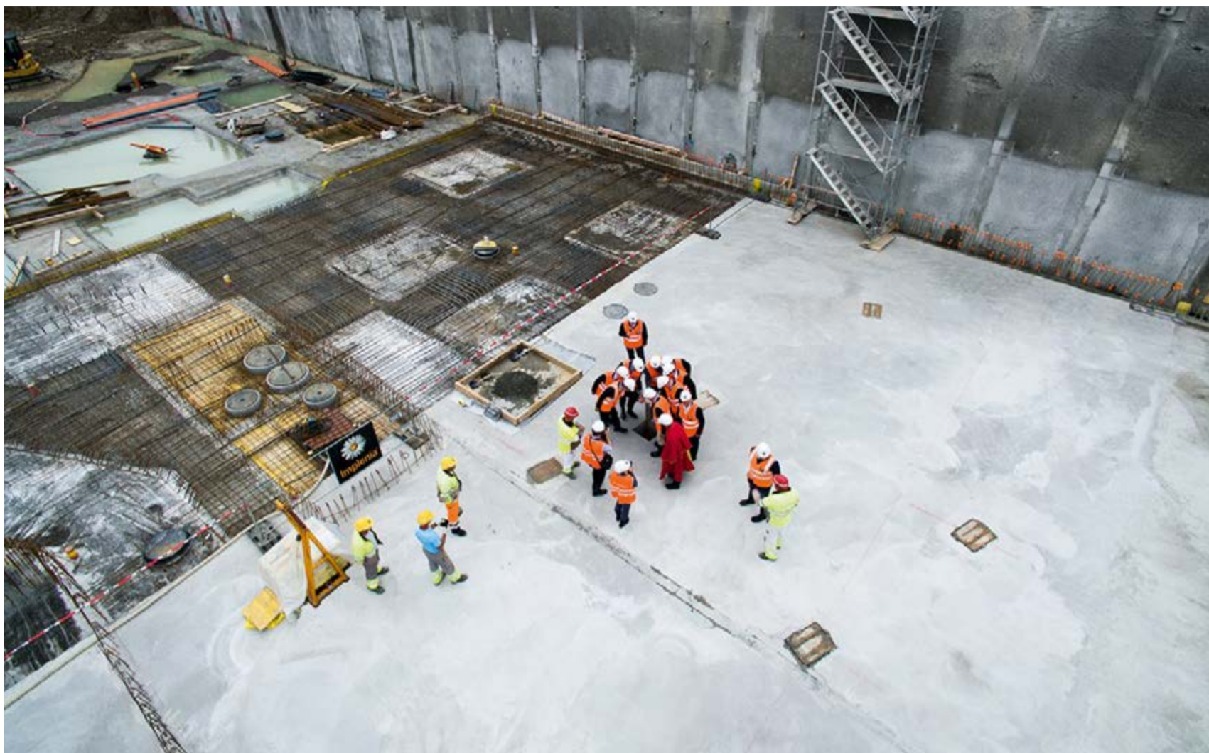
Die umfangreichen Bauarbeiten für den repräsentativen Neubau im Minergie-Standard sind seit Sommer 2016 im Gange und werden Anfang 2018 abgeschlossen sein.
