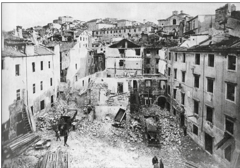
L'area risultante dalle demolizioni nel retro del Municipio in Cittavecchia (da Opere Pubbliche, a cura del Ministero LL.PP, 1935)
